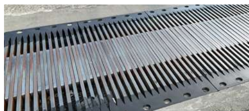
Giunto a lamelle longitudinali serie PG già installato su strade Anas Sardegna, Sicilia e sulla Grande comunicazione Firenze-Pisa-Livorno
